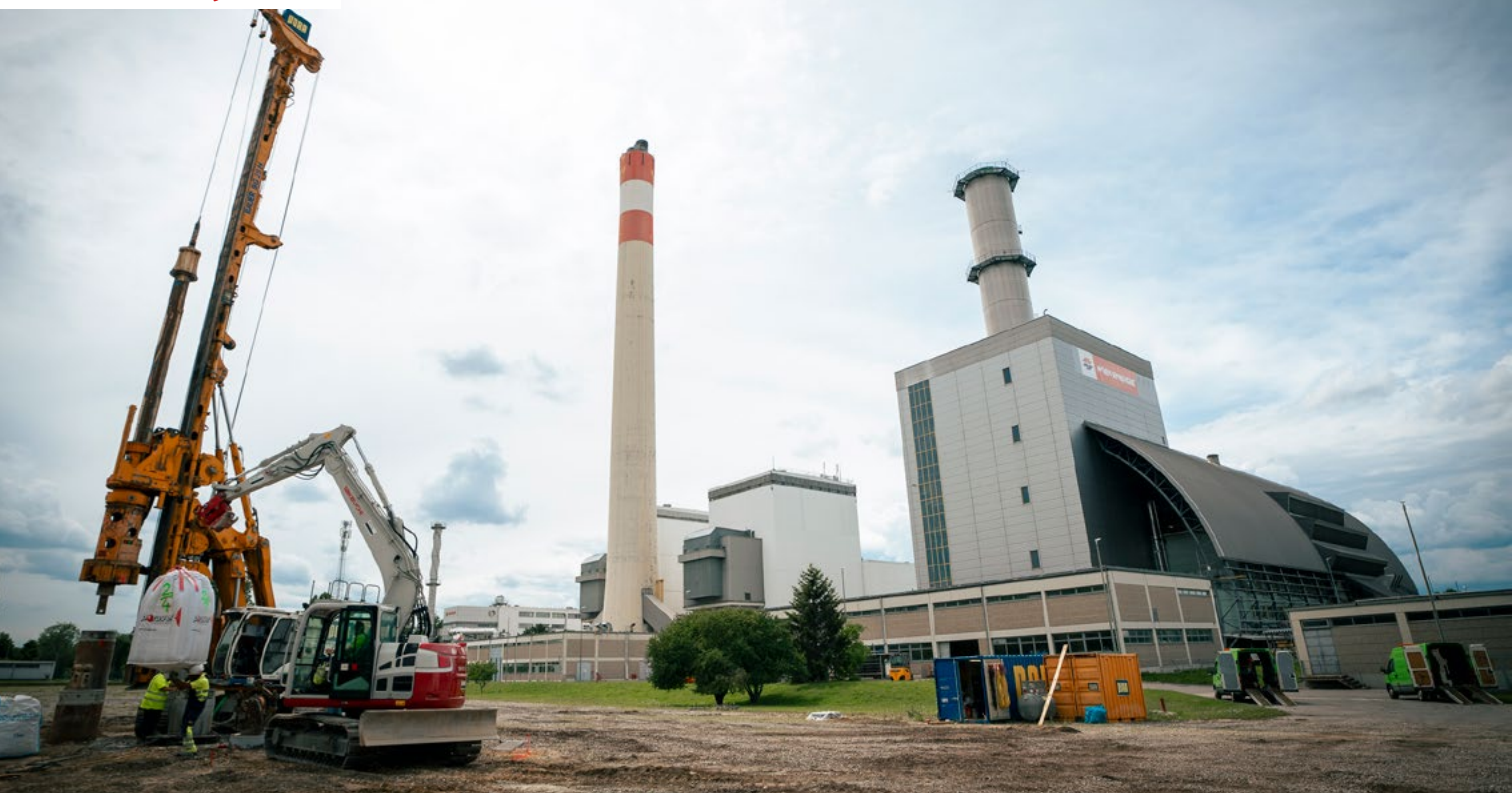
Bohrungen für die Dämmbohrpfahlwand. Dabei werden diverse Materialien für einen möglichen Einsatz beim späteren Bau des Wärmespeichers getestet. Foto: Wien Energie/Michael Horak
