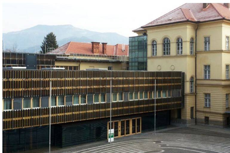
Wood/PV facade at the Höhere Bundeslehranstalt für Forstwirtschaft in Bruck a.d. Mur, photo: AEE INTEC/Armin Knotzer
